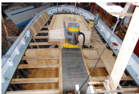
Den færdige dam med nyt bjælkelag
