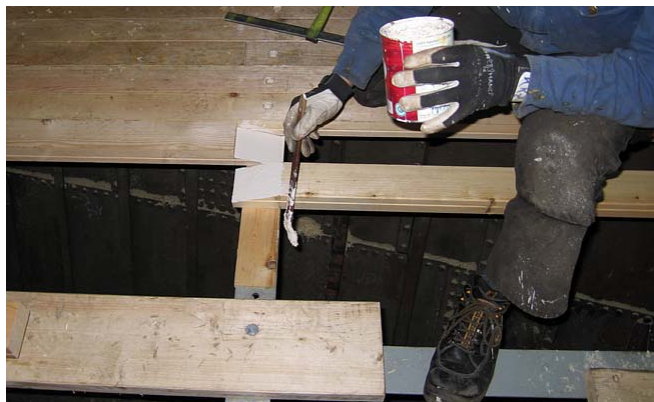
Dækslægning på stålskib. Skralasken er høvlet til. Fladerne bliver smurt med en zinkhvidt-oljeblanding inden de bliver lagt på hinanden for gennembolting. Foto: HFS
