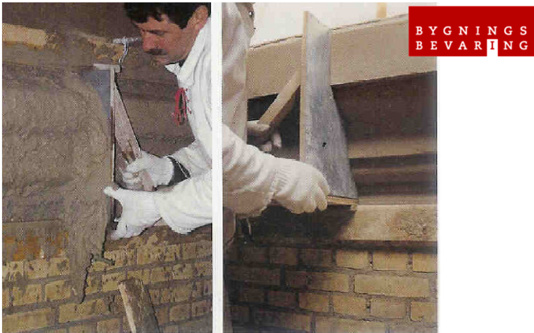
Hold 1: Restaurerings-håndværker, murer Niels Jørgen Knudsen i gang med at trække en facade-gesims i kalkmørtel. Niels Jørgen Knudsen var i Praktik i Østrig.
